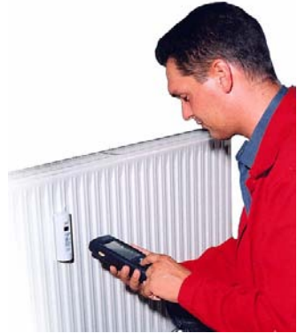
Abb. 2: Auch wenn immer mehr Messgeräte per Funk abgelesen werden, ist die Ablesung durch einen Service-Mitarbeiter vor Ort noch weit verbreitet.
