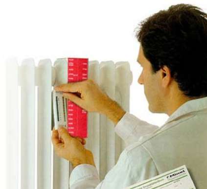
Abb. 4: Montage von Heizkostenverteilern. Wichtig ist die richtige Montagehöhe und die Einheitlichkeit in einem Gebäude.
