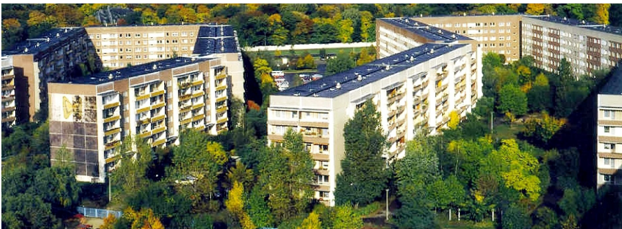
Abb. 9: Zu hohe Rohrwärme tritt vor allem bei falsch eingestellten vertikalen Einrohrheizungen auf, einem Heizsystem, das typischerweise in Plattenbauten verwendet wurde.
