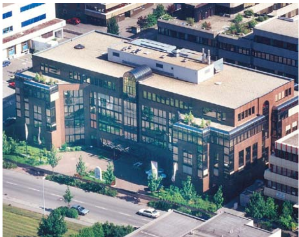
Abb. 1: Das Minol Messtechnik Verwaltungsgebäude in Echterdingen auf der Stuttgarter Filderhöhe. Es bietet auf 7.500 m 2 Fläche eine moderne und technisch hoch entwickelte Ausstattung.
