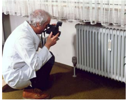
Abb. 5: Mit den Fotos der Heizkörper wird die richtige Erkennung des Heizkörpers durch Bewertungsspezialisten sichergestellt.
